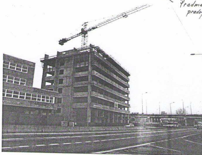
Situovanie pri Panónskej ceste
