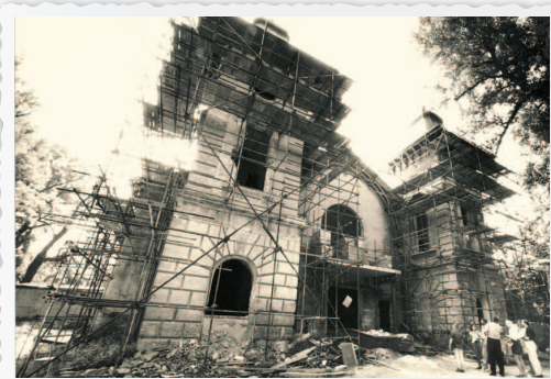
PN boli aj pri Sládkovej rekonštrukcii Arény.
