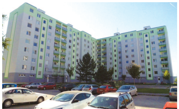
Panelák v Piešťanoch, druhé miesto v súťaži Najlepšie obnovený bytový dom v roku 2013, projektant Karol Ferencík.
