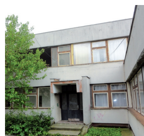
Druhá časť pôvodnej Materskej školy a jaslí na Znievskej 2 (ešteže v prvej časti je Súkromná ZŠ pre intelektovú nadaných žiakov).
