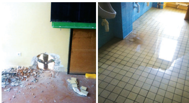
ZŠ Dudova – havária, ktorá vznikla z prasknutého potrubia v B1
