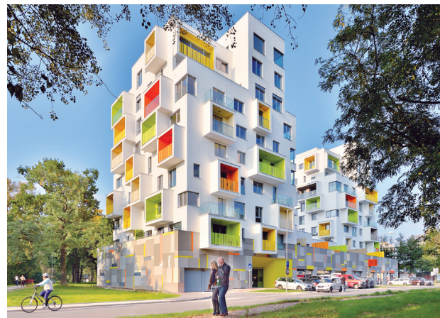
Novostavba Nový háj na rohu Dudovej a Starohájskej ulice s revitalizovaným parkom v pozadí. Jedným z autorov komplexu je aj Drahan Petrovič
