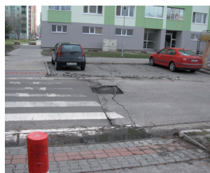
Černyševského ulica pred a po oprave.
