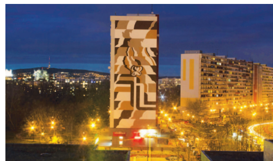
J. Porubčin – Obnovená malba cMier na bytovom dome na Osuského ulici
