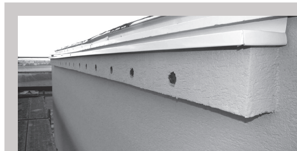
Náhradné bývanie pre dažďovníky
