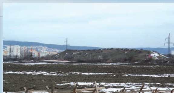
Pohľad z Jaroviec ponad umelý kopec. Na stožiare za ním by sa mali zavesiť drôty veľko-draždiakovej prekládky vysokého napätia, a tak obísť Petržalku.
