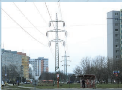
Drôty vstupujú do obývaných Lúk: od jazera popri Topoľčianskej ul., nad Jantárovou cestou na Šintavskú...
