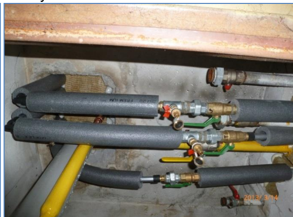
Po výmene rozvodov ZTI
