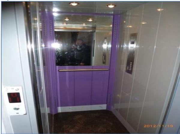
Výťah po rekonštrukcii
