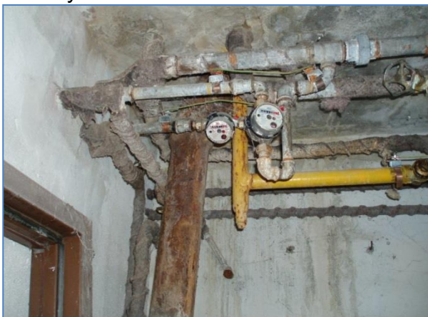
Pred výmenou rozvodov ZTI
