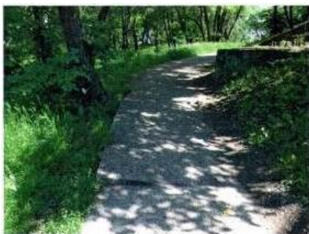
Obr. 2 Existujúci betónový chodník
