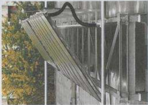
Celková plocha slnečných kolektorov je 3 050 m². Celkový výkon je 15,4 MW.
