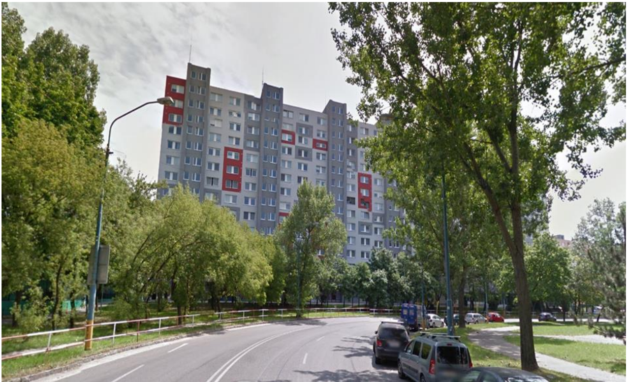
Kamerový systém č. 2 – Bytový dom Romanova 1
