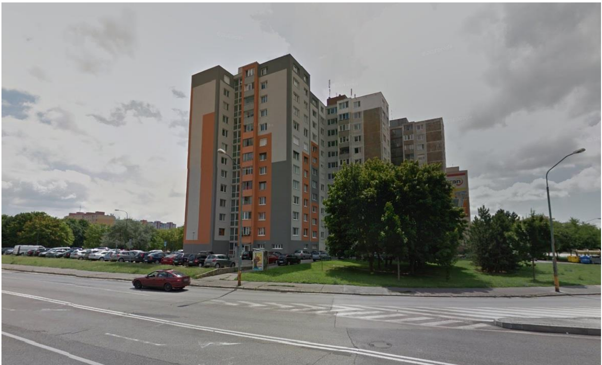
Kamerový systém č. 1 - Bytový dom Budatínska 3
