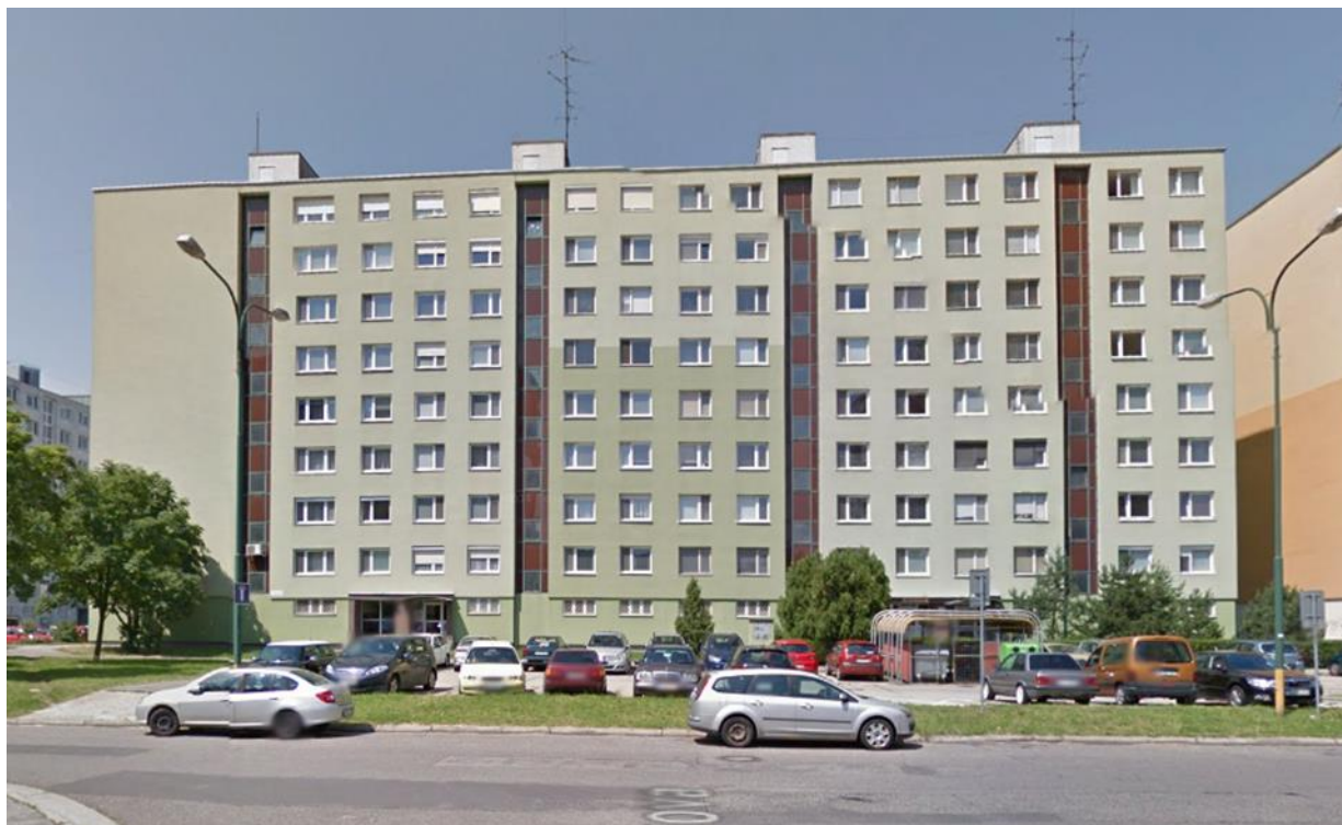
Kamerový systém č. 4 – Bytový dom Vavilovova 1
