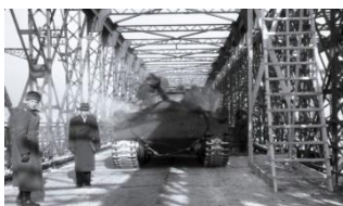
25. januára 1946 Zaťažkávacia skúška bratislavského mostu
