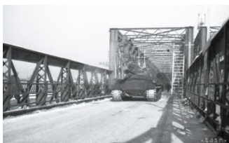
25. januára 1946 Zaťažkávacia skúška bratislavského mostu
