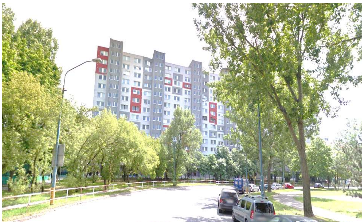
Kamerový systém č. 3 – Bytový dom Romanova 1
