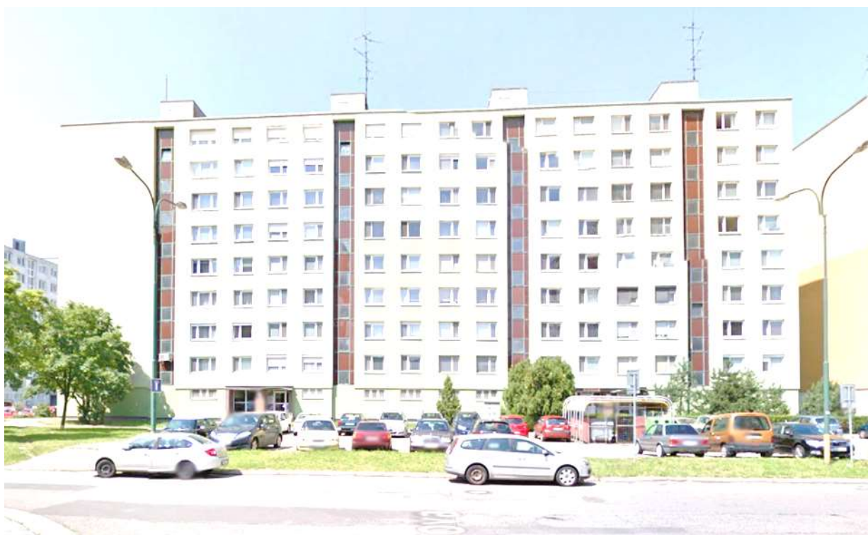
Kamerový systém č. 1 – Bytový dom Vavilovova 1
