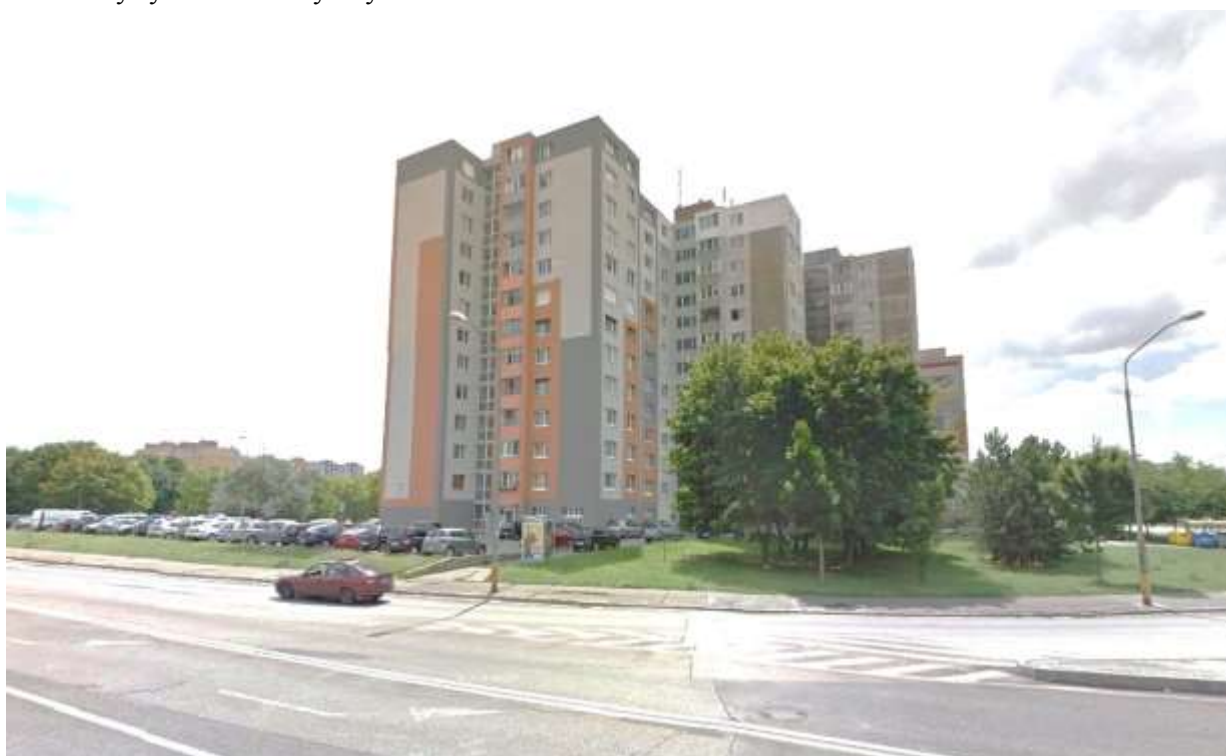
Kamerový systém č. 4 - Bytový dom Budatínska 3
