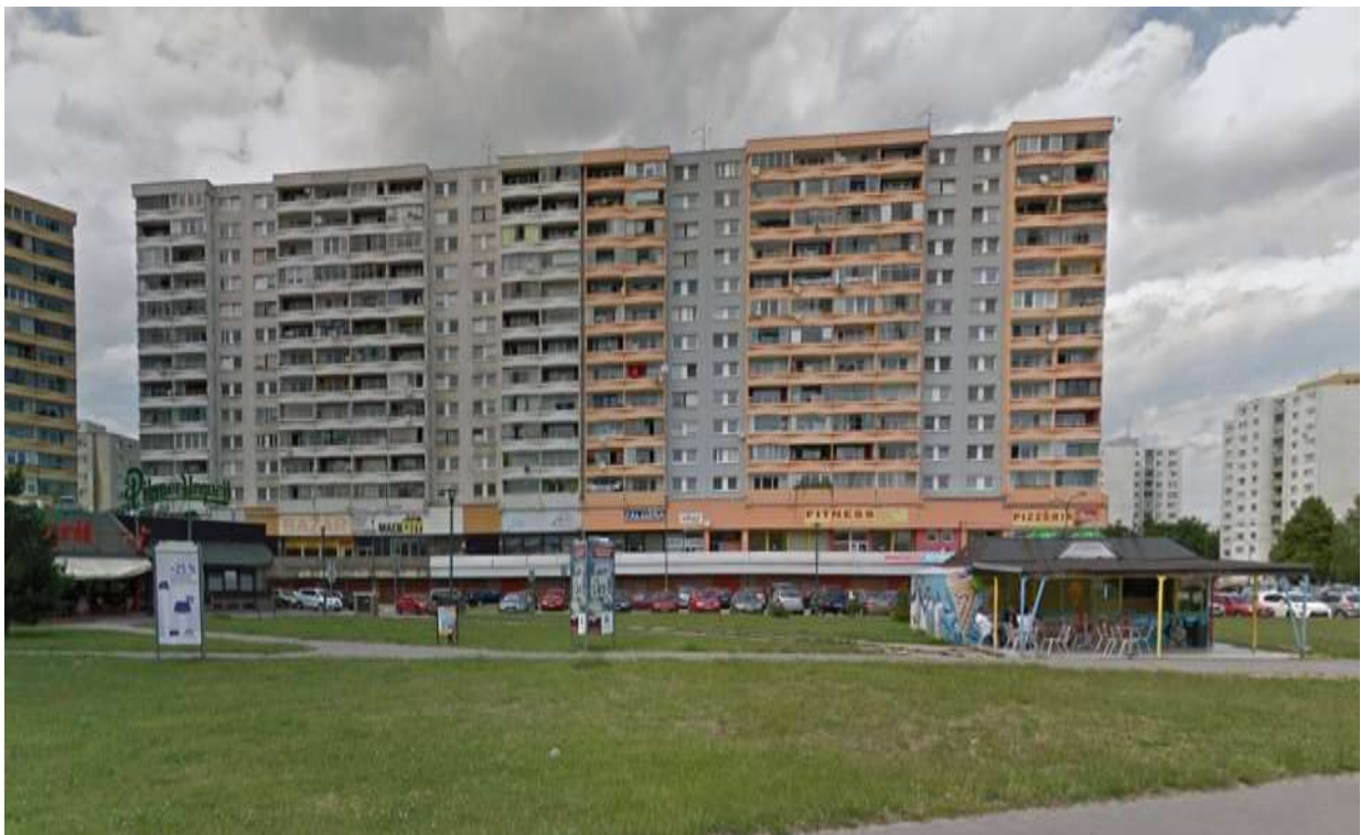
Kamerový systém č. 2 – Bytový dom Romanova 1
