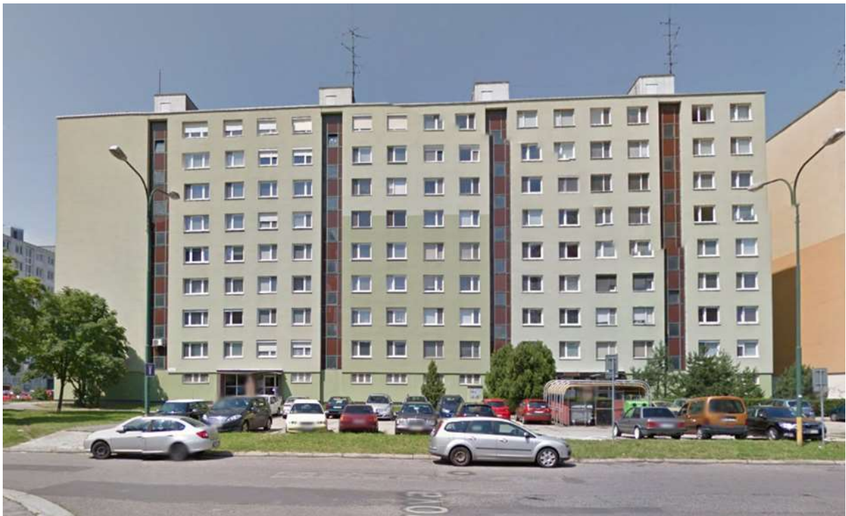
Kamerový systém č. 4 – Bytový dom Vavilovova 1
