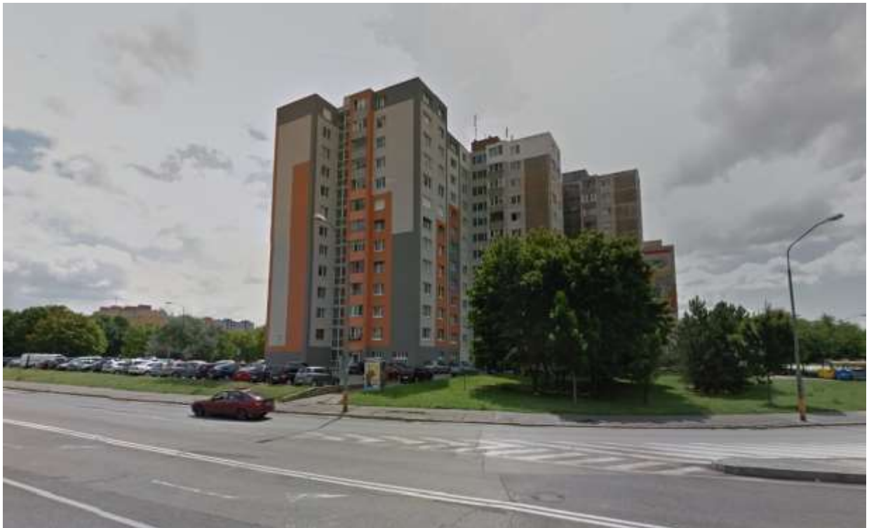
Kamerový systém č. 1 - Bytový dom Budatínska 3
