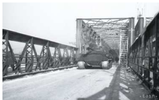
25. januára 1946 Zaťažkávacia skúška bratislavského mostu
