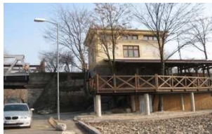
Mýtny domček – bývalá colnica, koniec 19. storočia
