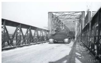
25. januára 1946 Zaťažkávacia skúška bratislavského mostu
