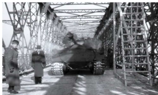
25. januára 1946 Zaťažkávacia skúška bratislavského mostu
