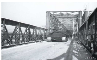
25. januára 1946 Zaťažkávacia skúška bratislavského mostu
