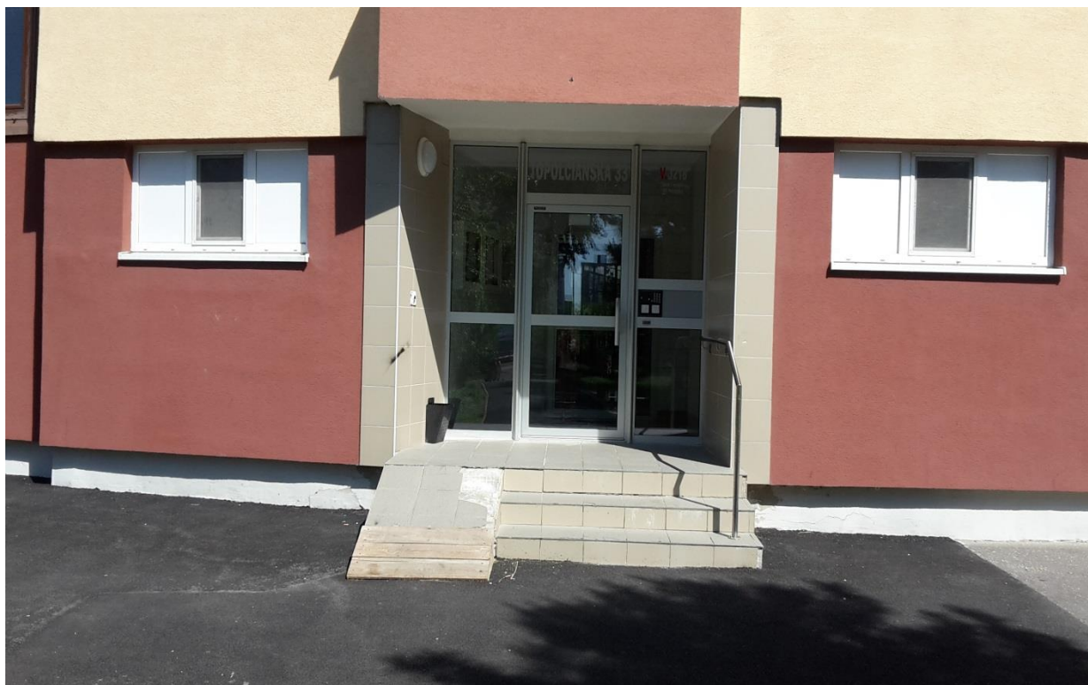
Obrázok č. 1 Vchod do bytového domu Topoľčianska 33
