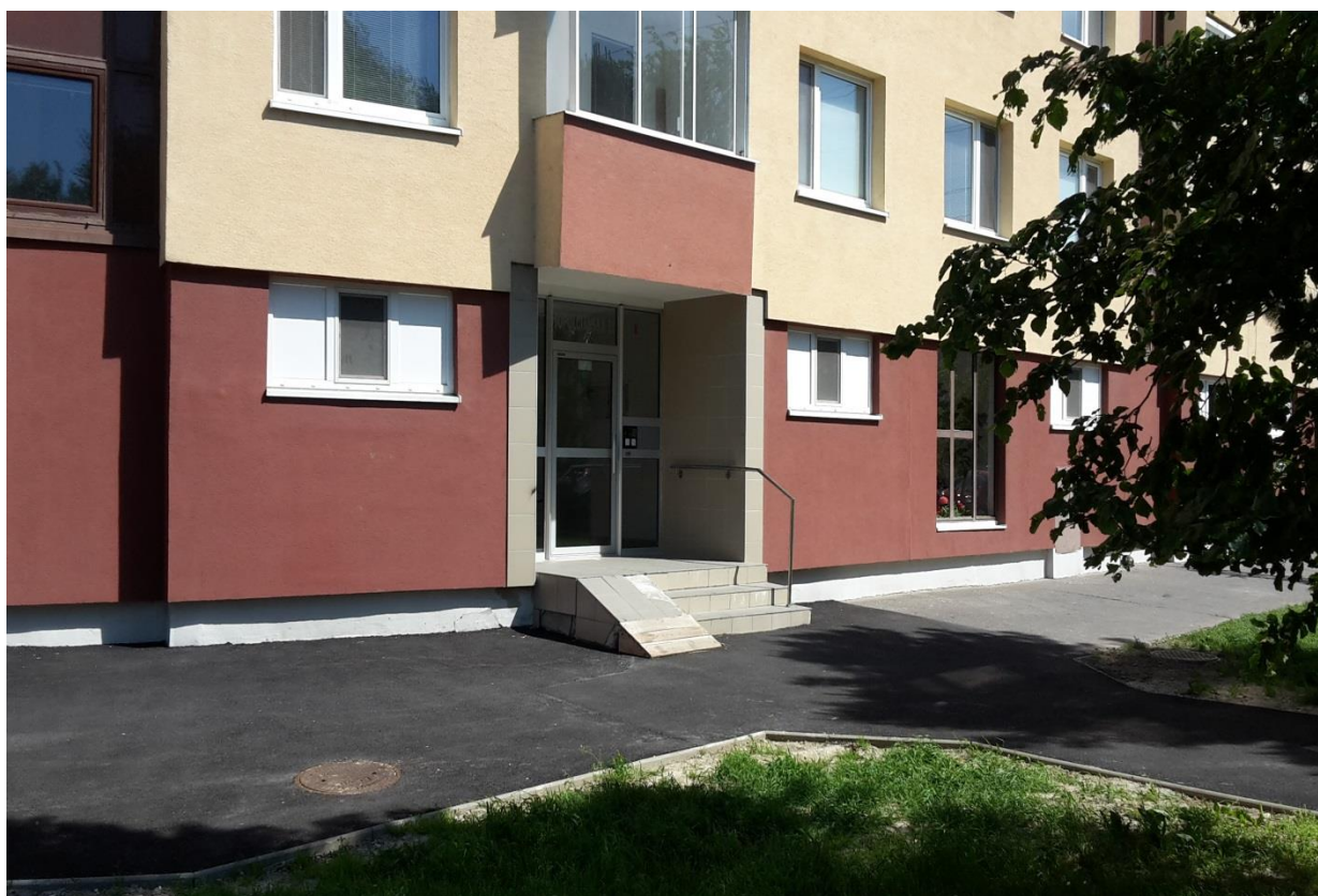
Obrázok č. 2 Vchod do bytového domu Topoľčianska 33
