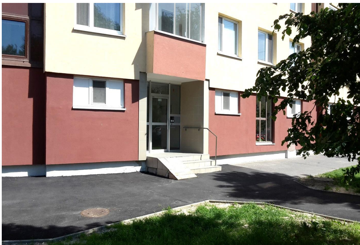
Obrázok č. 2 Vchod do bytového domu Topoľčianska 33
