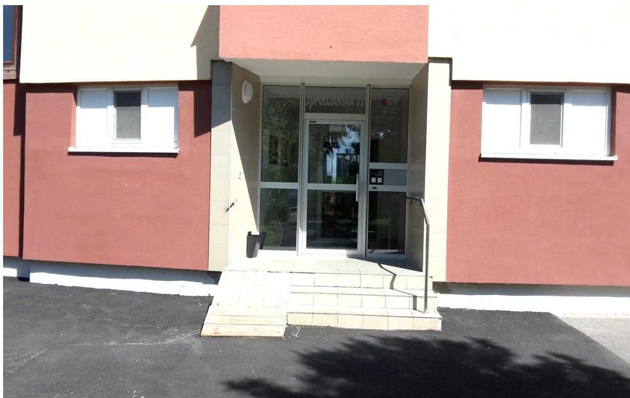
Obrázok č. 1 Vchod do bytového domu Topoľčianska 33
