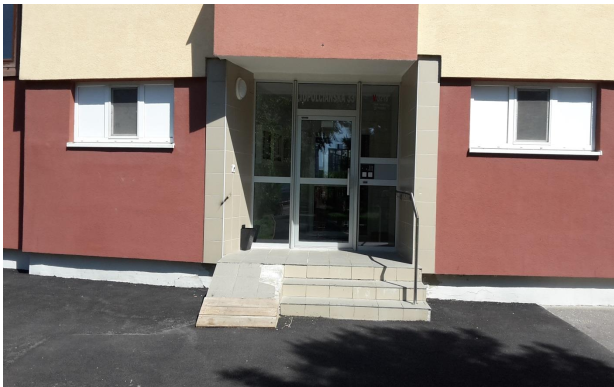
Obrázok č. 1 Vchod do bytového domu Topoľčianska 33
