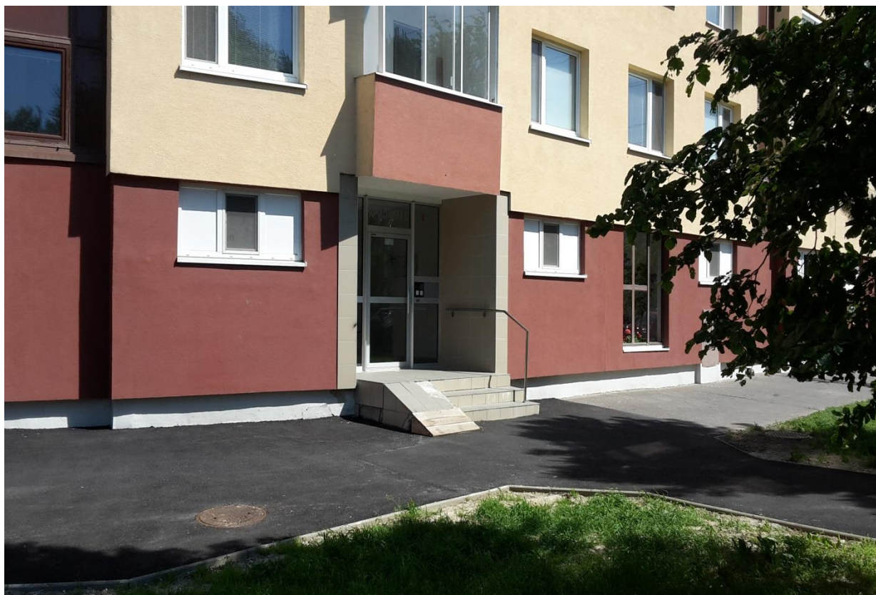
Obrázok č. 2 Vchod do bytového domu Topoľčianska 33
