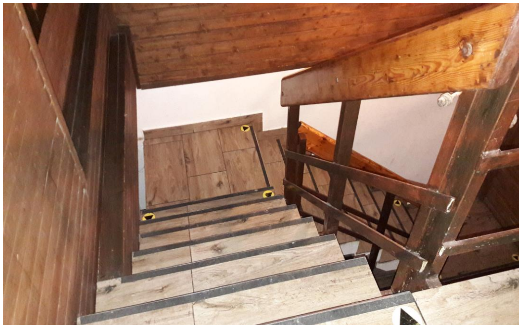
schodisko do suterénu
