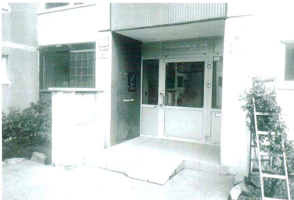
Pohľad na vstupné schodisko do objektu
