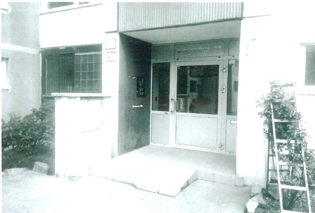
Pohľad na vstupné schodisko do objektu
