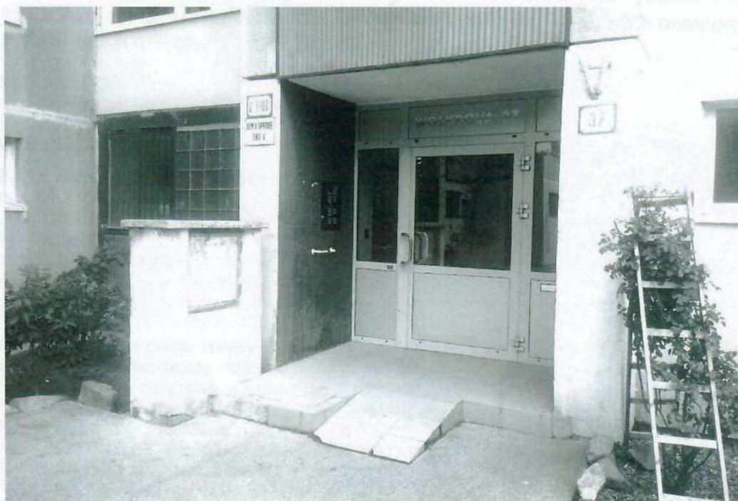
Pohľad na vstupné schodisko do objektu
