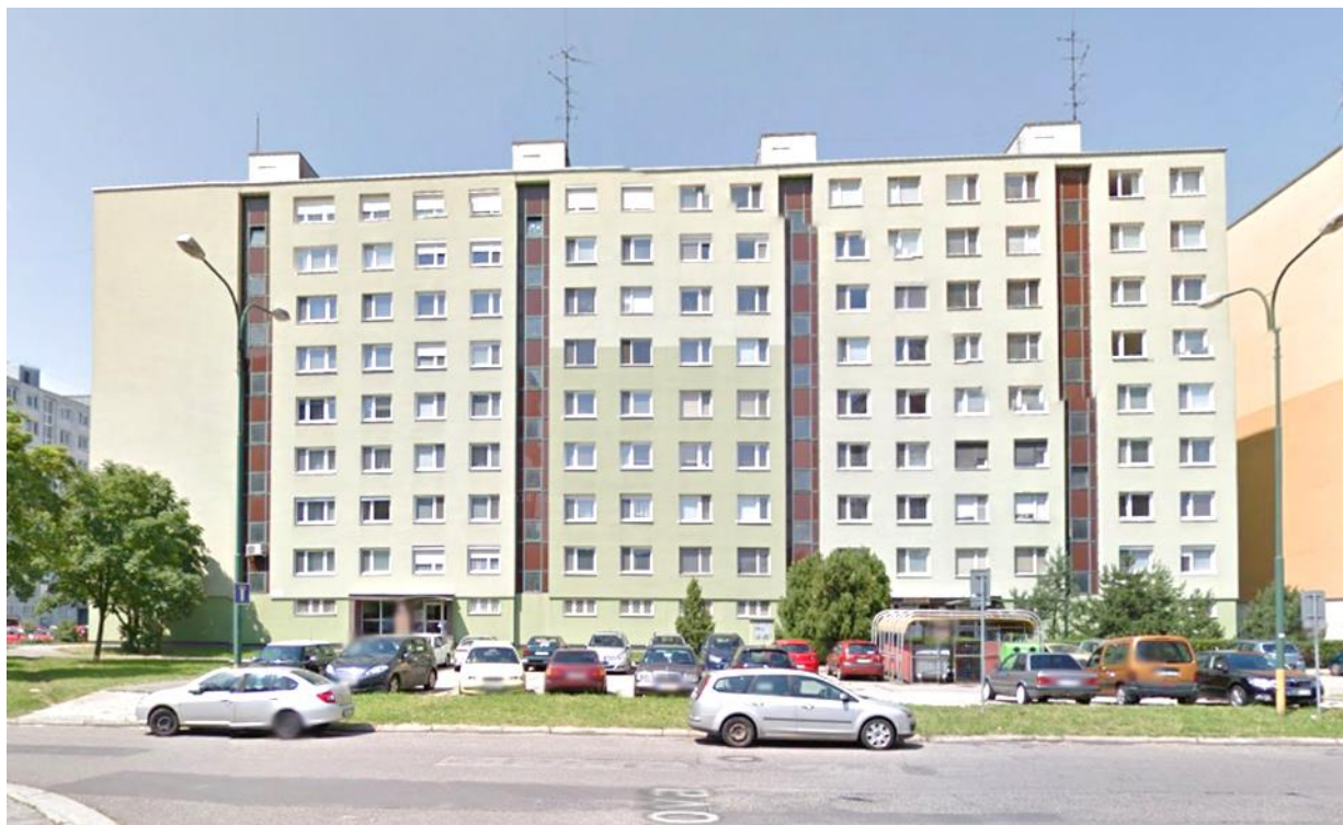
Kamerový systém č. 1 – Bytový dom Vavilovova 1
