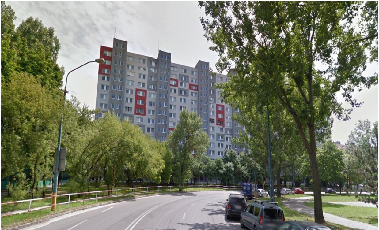
Kamerový systém č. 3 – Bytový dom Romanova 1
