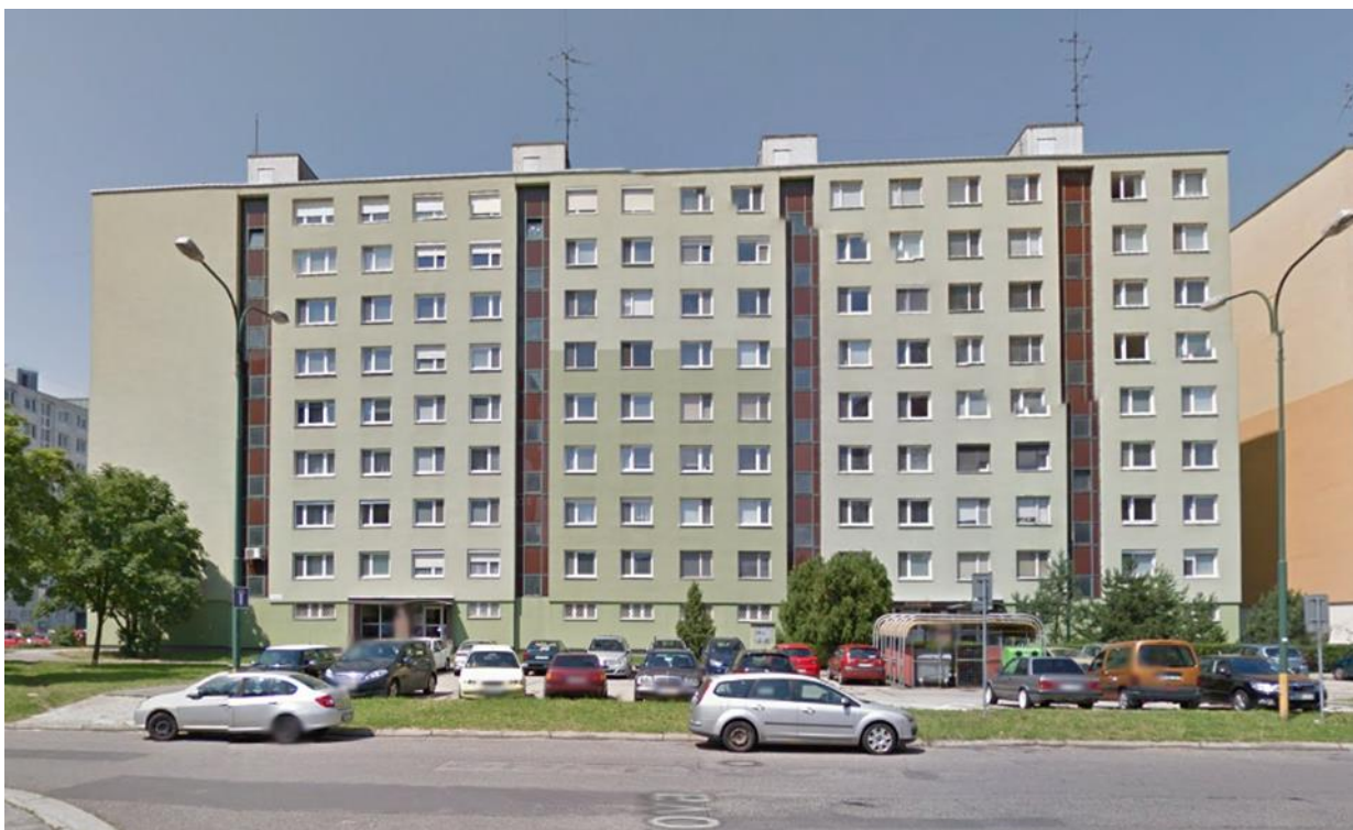
Kamerový systém č. 1 – Bytový dom Vavilovova 1
