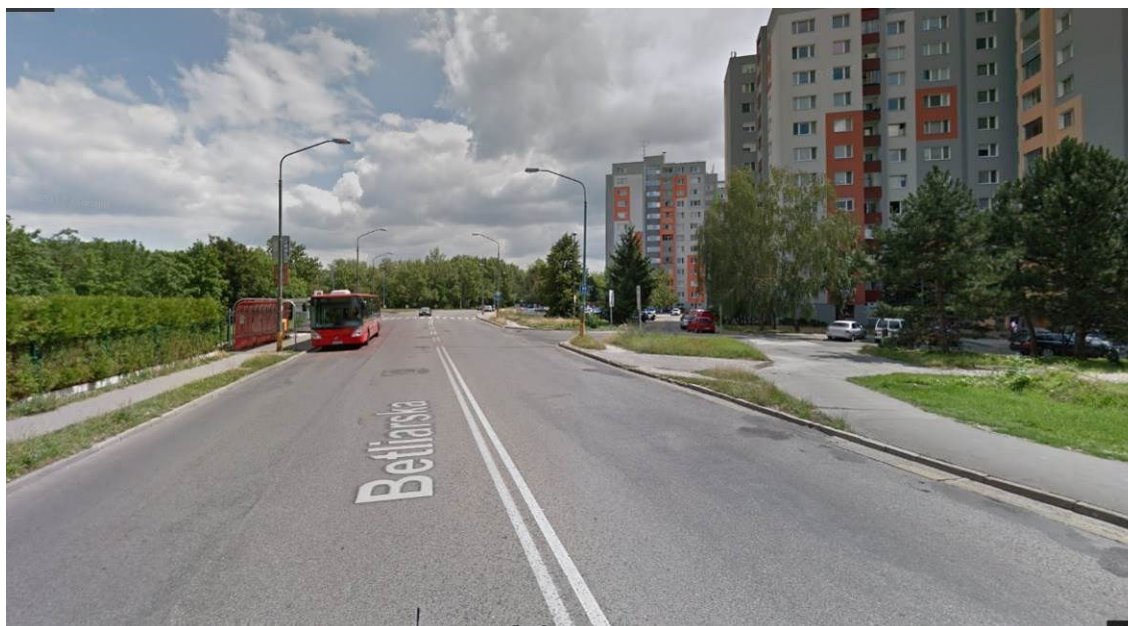
Chýbajúci bezbariéroví prístup zo zastávky MHD k Nemocnici sv. Cyrila a Metoda
