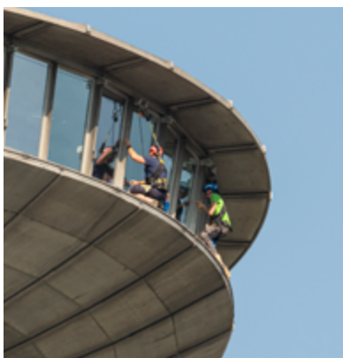
Čističi okien na Vyhliadkovej veži UFO
