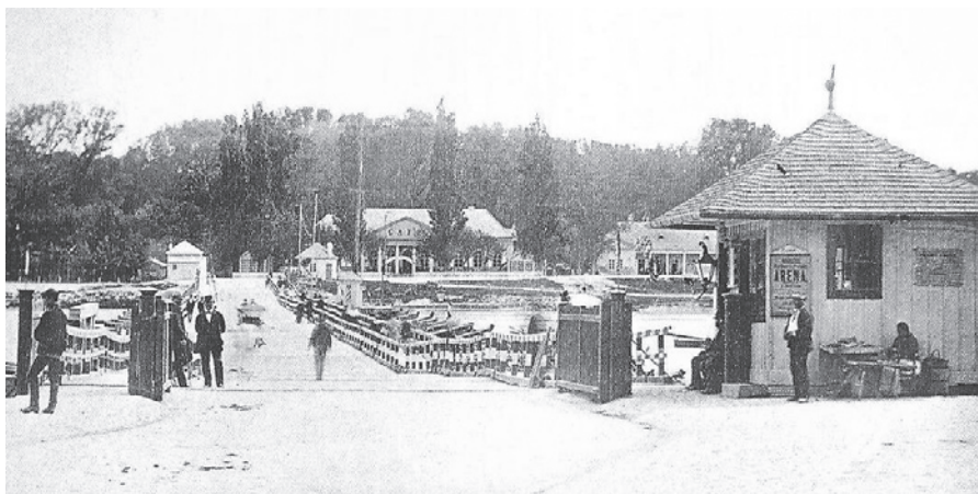
Obr. č. 19: Most Karolíny Augusty z bratislavskej strany. V pozadí, na petržalskej strane, vidíme budovu Au Café a vedľa reštauráciu Leberfinger. Na strážnej búde je leták s pozvánkou na podujatie v Aréne. (MKP)
