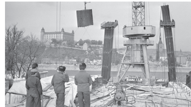
Výstavba bratislavského Mosta SNP v roku 1969
