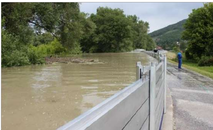
Fotografia č.18: Mestskú časť Bratislava-Devín chráni pred povodňou mobilná protipovodňová hrádza – rok 2013. Zdroj: Webový portál Ministerstva vnútra Slovenskej republiky https://www.minv.sk/?fotogalerie-5&galeria=povodne-jun-2013-devin-bratislava .
