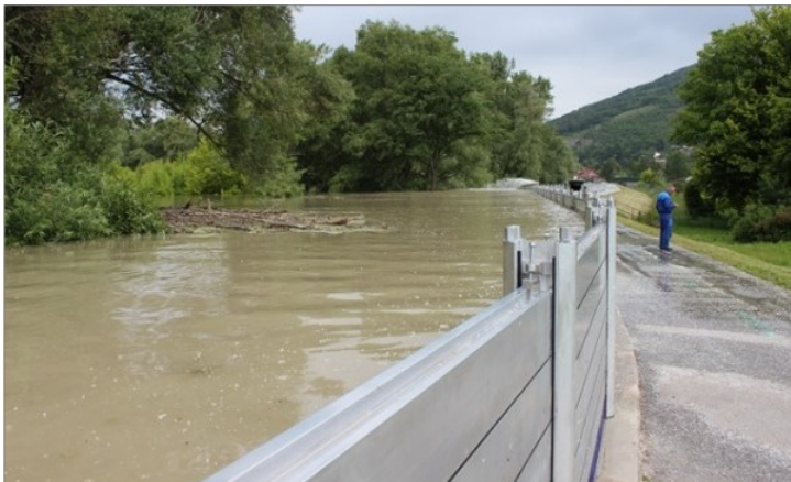
Fotografia č. 18: Mestskú časť Bratislava-Devín chráni pred povodňou mobilná protipovodňová hrádza – rok 2013.
