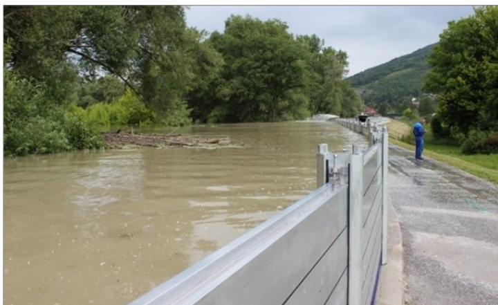
Fotografia č. 18: Mestskú časť Bratislava-Devín chráni pred povodňou mobilná protipovodňová hrádza – rok 2013.
