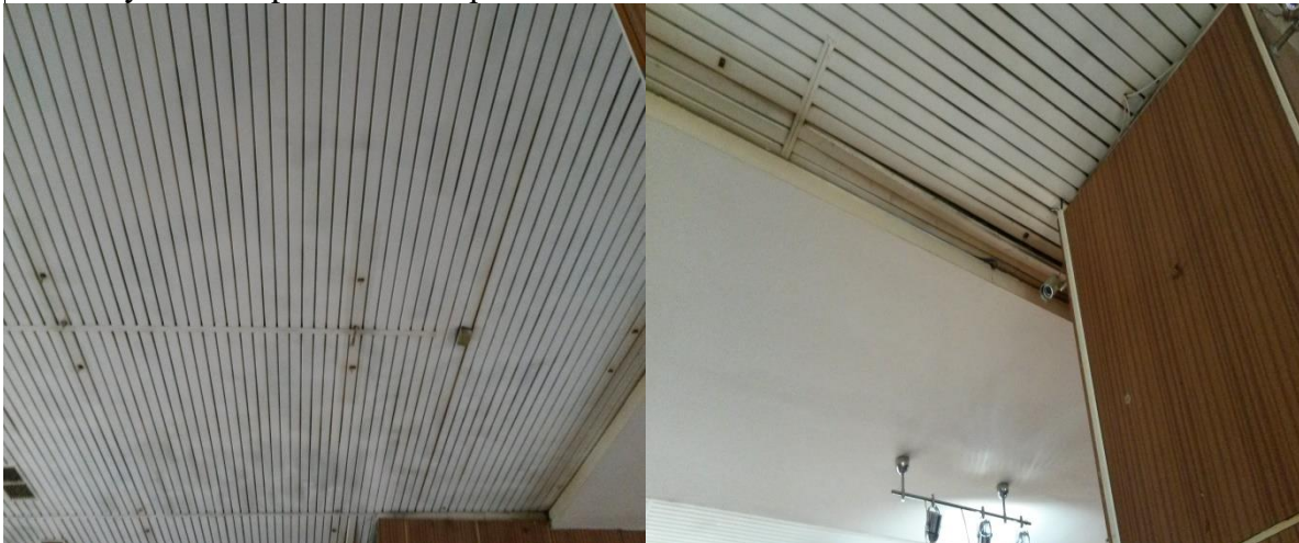
Podhľady v celom priestore sú v pôvodnom stave taktiež obklad na stenách
