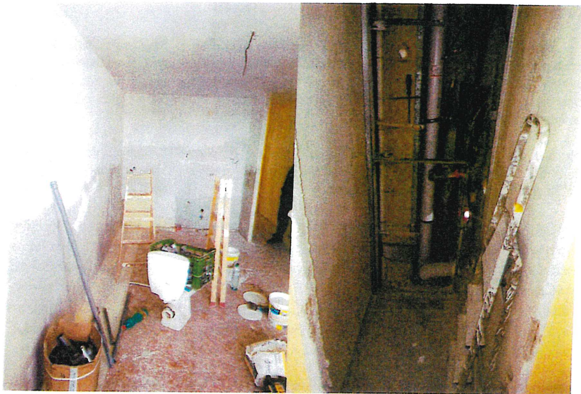
Prebiehajúca rekonštrukcia obecných bytov na ul. Medveďovej 21 v Bratislave
