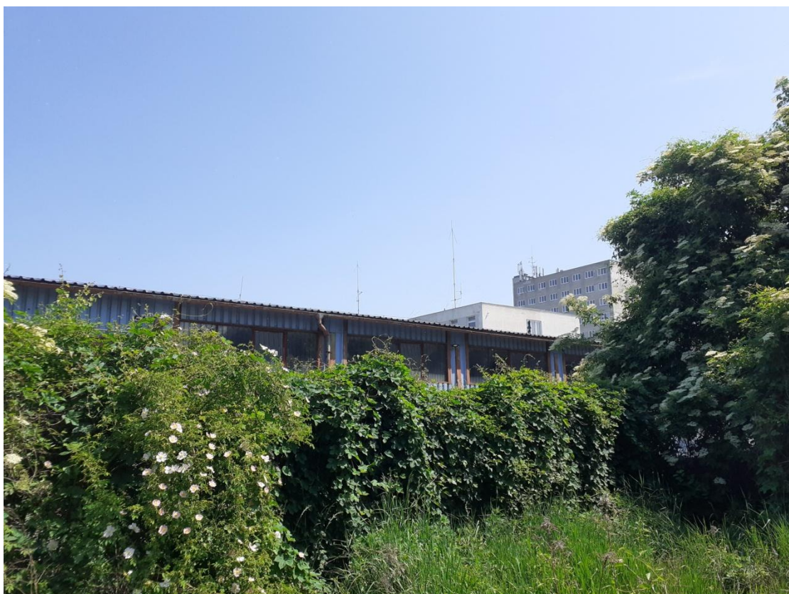
Územie stavebného bloku H1
