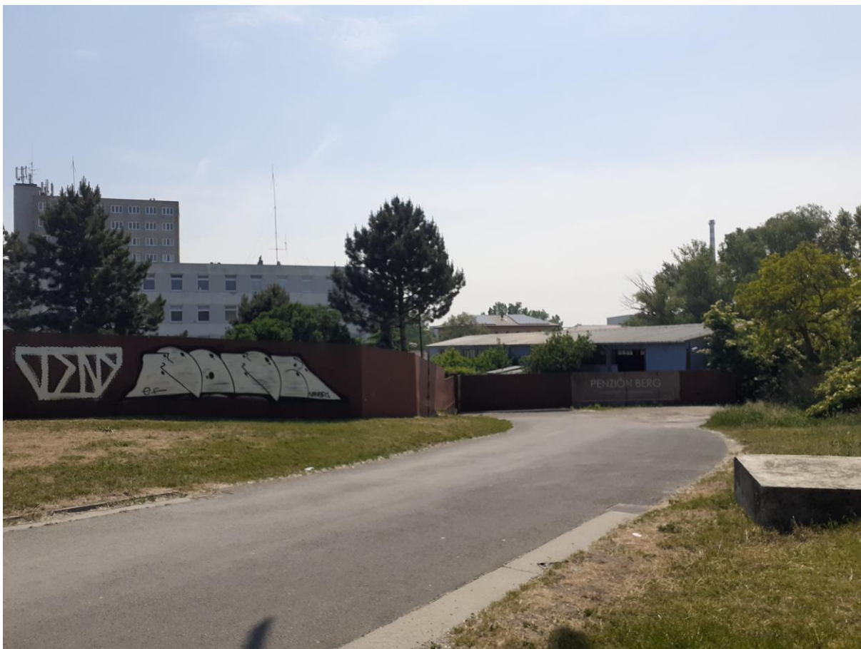
Dopravné pripojenie zóny na Viedenskú cestu – súčasný stav – komunikácia je len čiastočne spevnená, do zóny pokračuje ako poľná cesta
