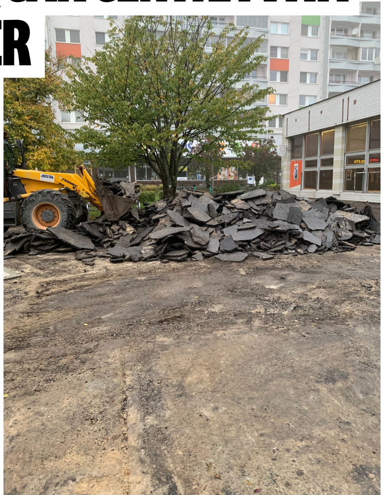
Práce na revitalizácii asfaltovej plochy pred Cik Cak Centrom. | FOTO: MiÚ Petržalka
