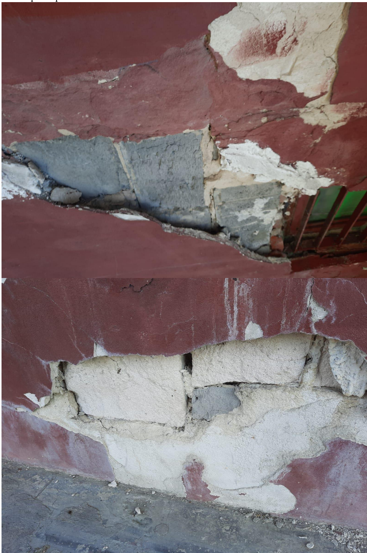
Fasáda pred opravou:
