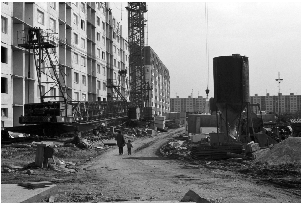
Ešte dlho po tom, čo sa do Petržalky nasťahovali noví obyvatelia, bolo celé sídlisko jedným veľkým staveniskom. Nie nadarmo sa hovorilo, že Petržalčania chodili domov v zablatených topánkach. | FOTO: Kamil Beladič (GIB)
