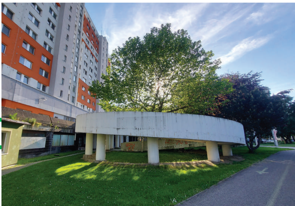
Hmota a kompozícia priamych i oválnych rámp vedúcim k terasám sú súčasťou architektonického výrazu a ozvlášťujú sídliskovú výstavbu. | Foto: Zora Pauliniová
