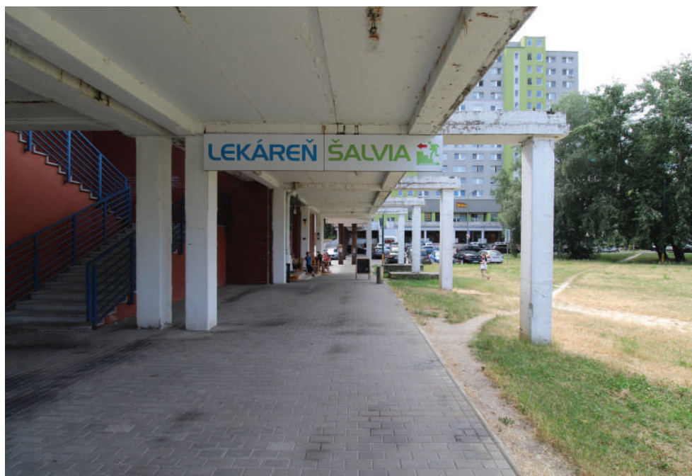
Rozšírená nosná konštrukcia terasy pri dome služieb – relikv prepojenia na kultúrno-spoločenské centrum | Foto: Viktor Kasala
