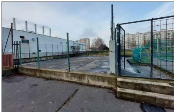
Asfaltové ihrisko s betónovou stenou
