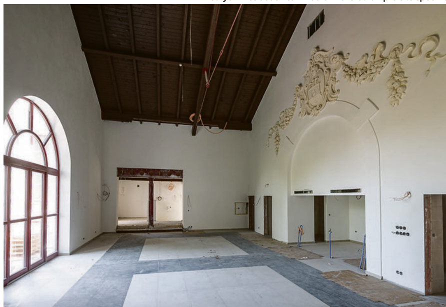
Momentálne sa realizujú dokončovacie práce najmä v interiéri divadla. | Foto: Monika Kováčová/BSK
