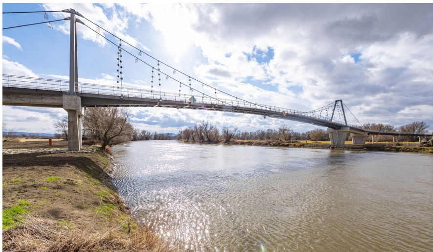
Výstavba mosta VysoMarch začala v apríli 2021, otvorili ho 7. mája 2022. Je dlhý 270 metrov a široký 4 metre. | Foto: BSK
