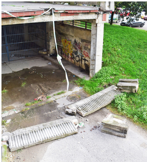
Pád betónového zábradlia na terase na Znievskej 17 bol len potvrdením komplexného monitoringu terás, ktorý realizovala mestská časť. | Foto: Ivana Vrabľová
