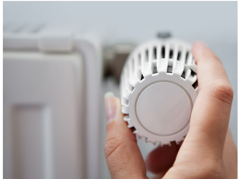
Je dôležité, aby termostatické hlavice na radiátoroch boli ešte pred spustením vykurovania otvorené na maximum. Predíde sa tým komplikáciám so zavzdušením systému. | Foto: Veolia
