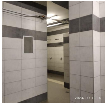
Obnovené šatne a toalety
