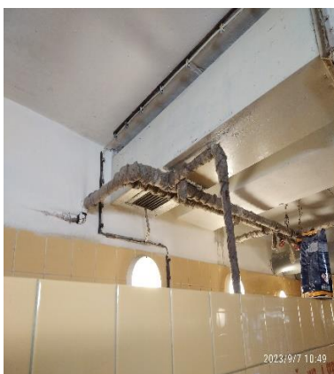
Inštalácia VZT, ZTI
