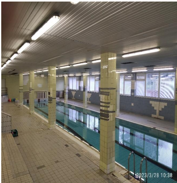
Stav pred sanáciou -bazénová hala
