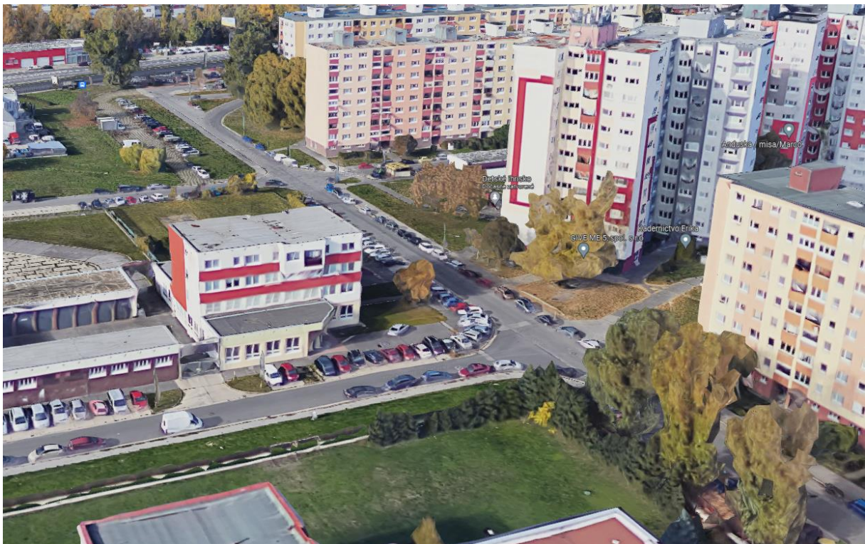
Súčasný stav lokality. V okolí sa nachádza prevažne zástavba obytného typu formou bodovej (12NP) a líniovej (8NP) zástavby panelových bytových domov.
