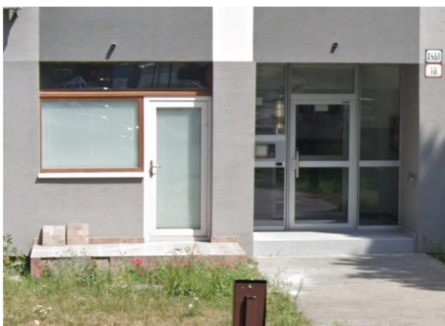
Nám. Hraničiarov 19 - prístupový chodník
