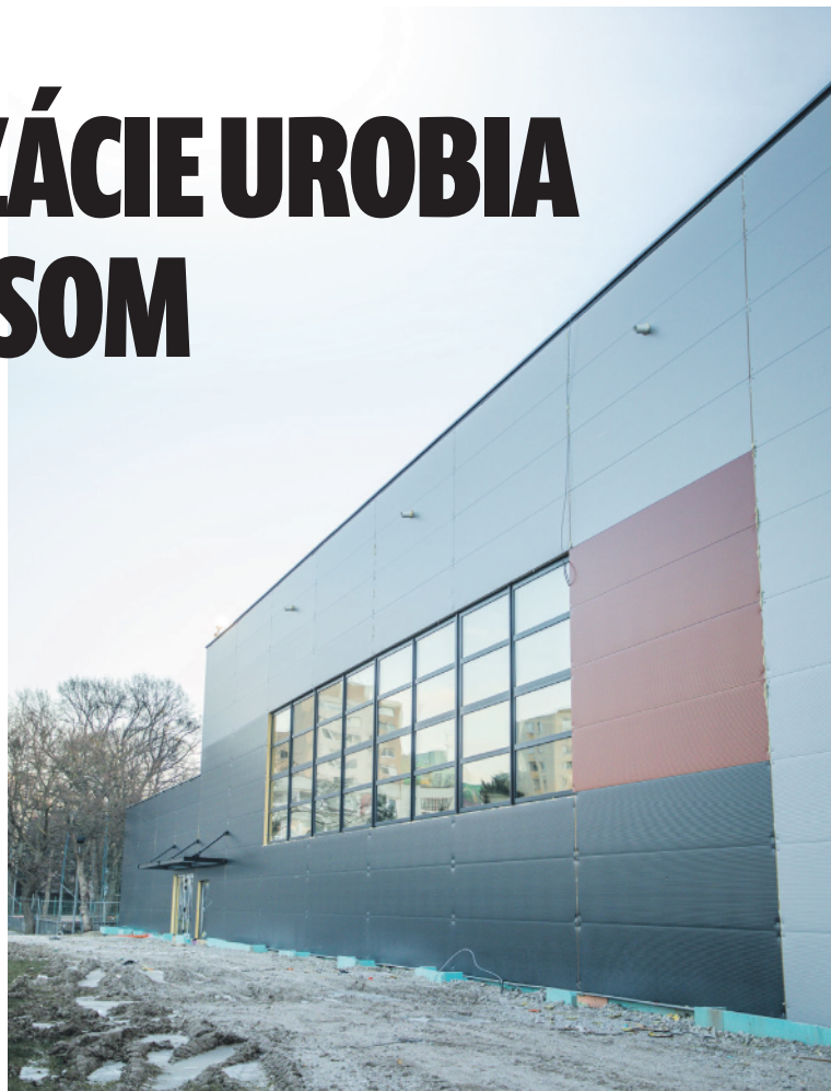
Výstavba haly na Pankúchovej patrí k najväčším investičným akciám Petržalky. Mestská časť na ňu získala 1,2 milióna z externých zdrojov. | Foto: Ivana Vrabľová
